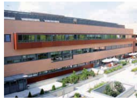
Fachada de la Fundación Vianorte-Laguna.
